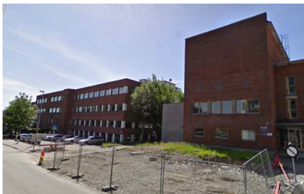
Lørenveien 51 med tiliggende trafostasjon i øst
